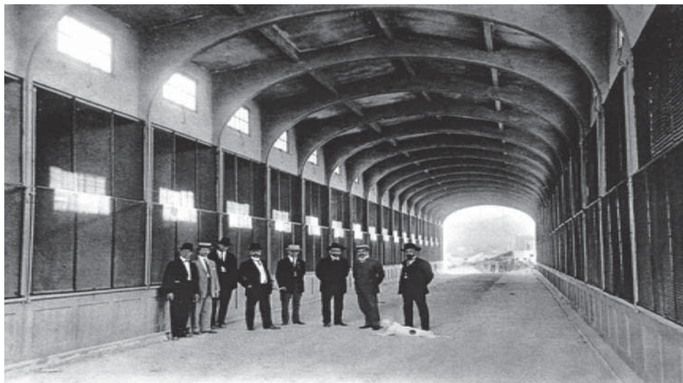
Foto 2. Vista del interior del puente de San Luisito en 1904
